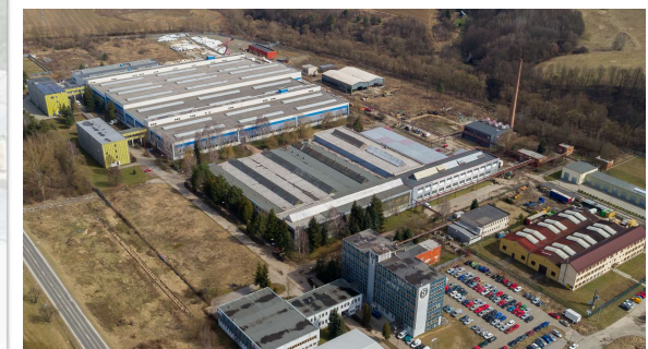
CHARVÁT Strojárne Bardejov SK
