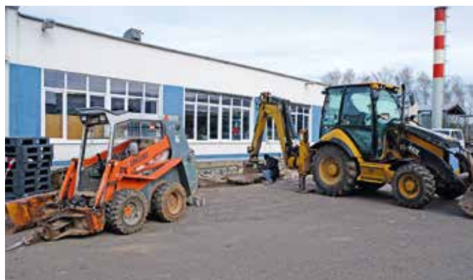
■ Přípravné stavební práce začaly v poslední dekádě března. Na snímku skrytí asfaltové vrstvy na nádvoří před halou, příprava na hloubení základů
