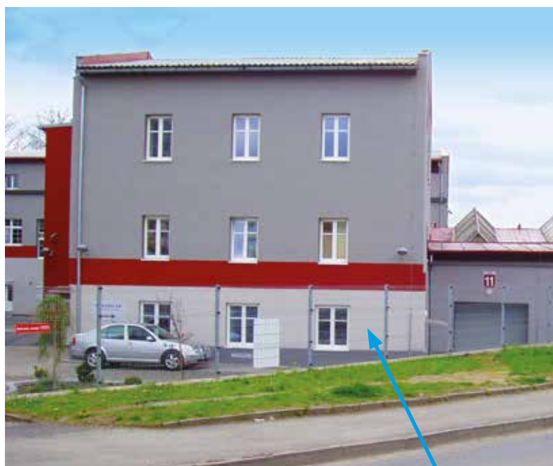
■ Stávající provozovna Charvát Group s.r.o. v Plzni, snížené přízemí
