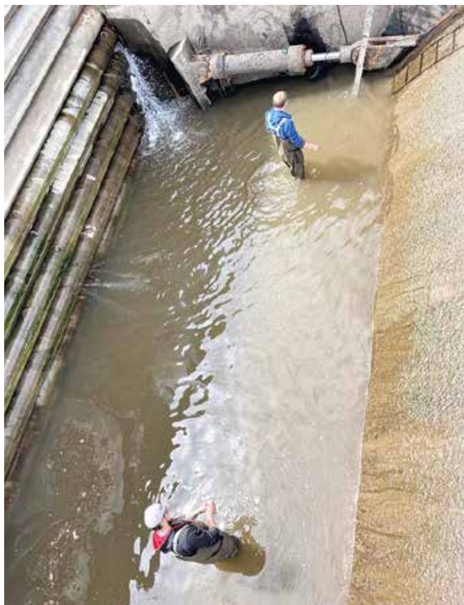
■ Technici Hykomu pracují v náročných podmínkách.
