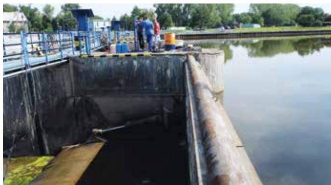
■ Uzavřená jezová klapka. Nad ní proti proudu přepažení přístupu Labe do prostoru oprav. Tuto zábranu zasunuje do jezu lodní jeřáb.
